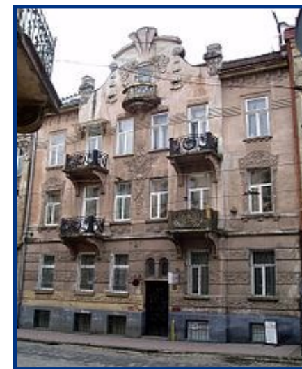
Нечуя-Левицького, 13 Кам'яниця виконана у стилі сецесія, пишно декорована ліпниною, яка доповнена кованими балюстрадами балконів. Фасад у центральній частині завершується криволінійним, високим аттиком.
