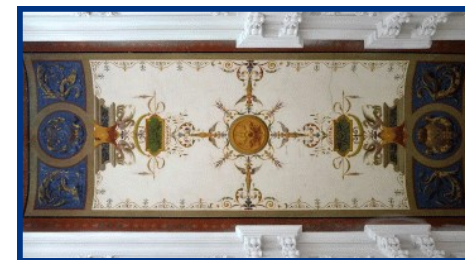
Вілла на вул. Глібова, 15 Оздоблення стелі у коридорі
